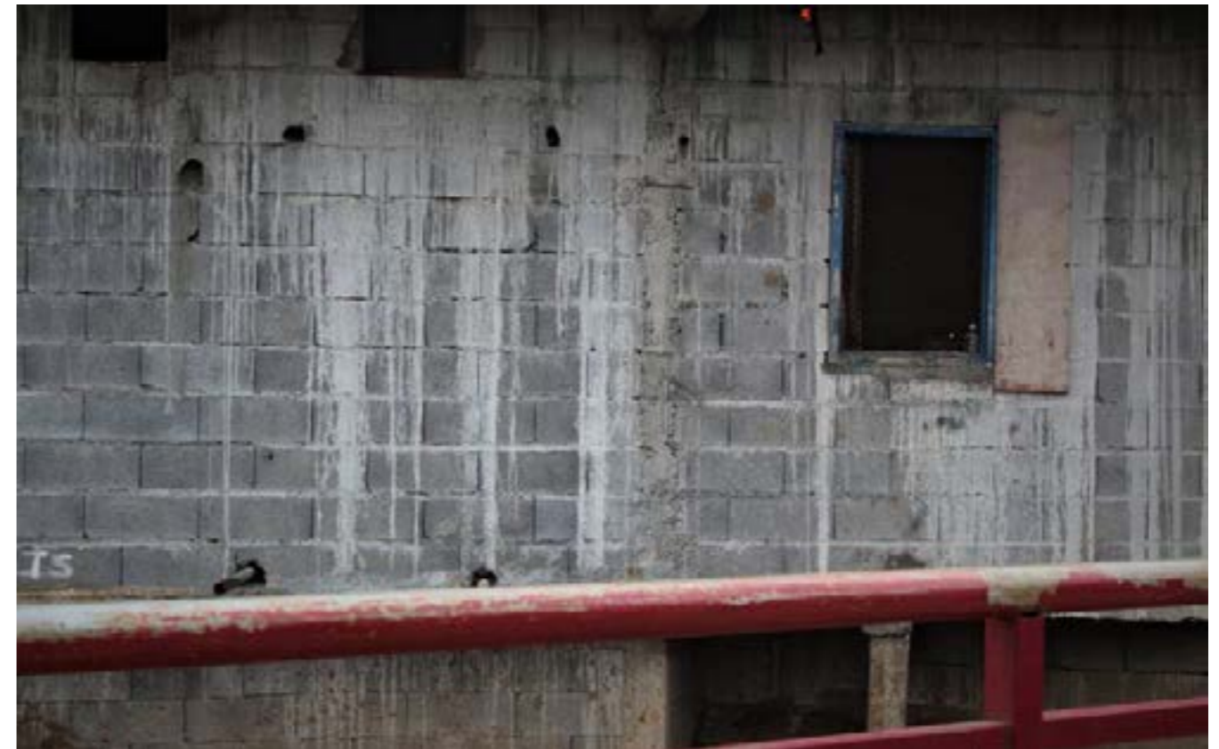
Le mur d'une maison située au-dessus du pont à Kawéni (Hilma).
