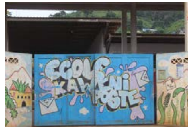
Le portail de l'école de Kawéni Poste, avec sa peinture un peu usée et abîmée (Harafo).
