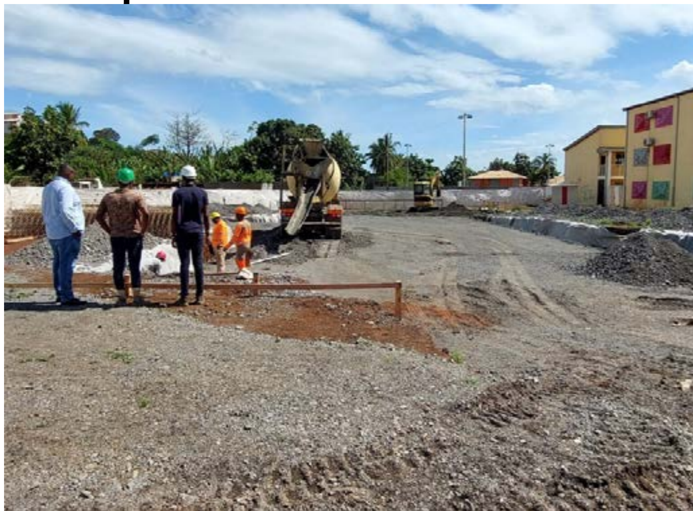
Premiers coups de pelletée pour les fondations du réfectoire de l'école Maraîchers
