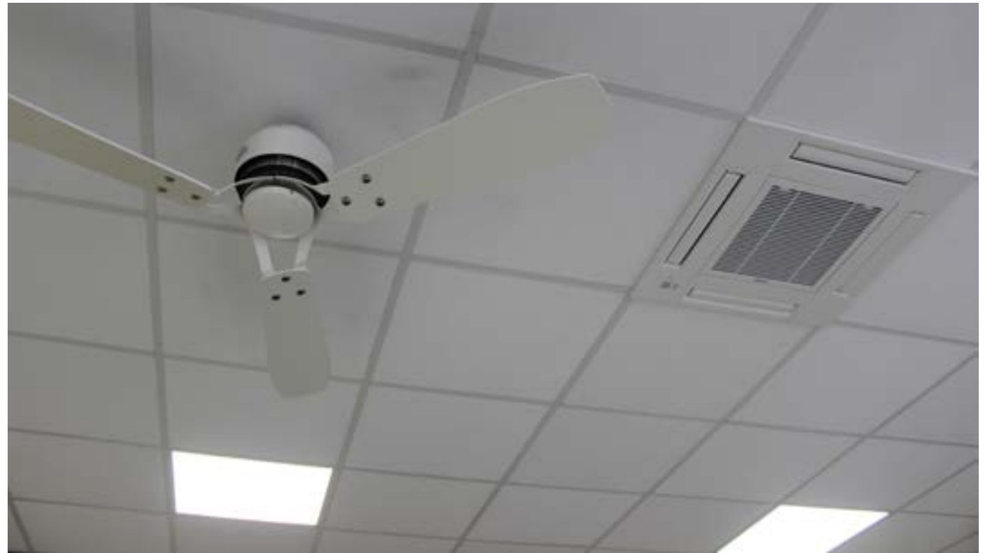
Des nouveaux climatiseurs, des brasseurs d'air et des éclairages LED sont installés dans la trentaine de salles rénovées.
