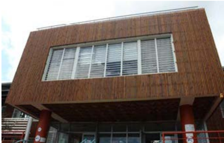
Le nouveau bardage bois du CUFR permet une atténuation de l'ensoleillement direct.
