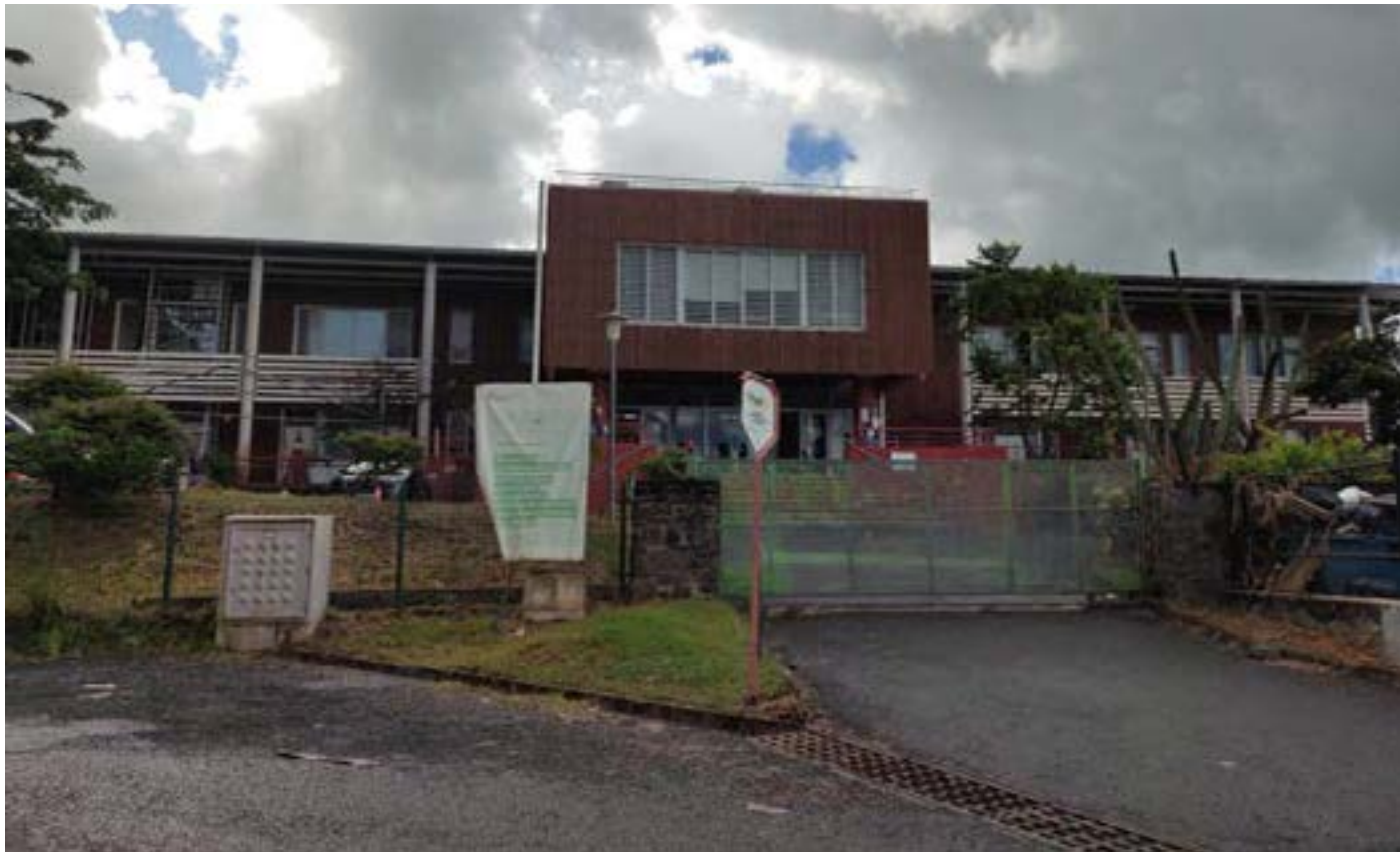
Un bardage bois est installé sur la devanture du centre universitaire de Mayotte lors des travaux de rénovation énergétique.
