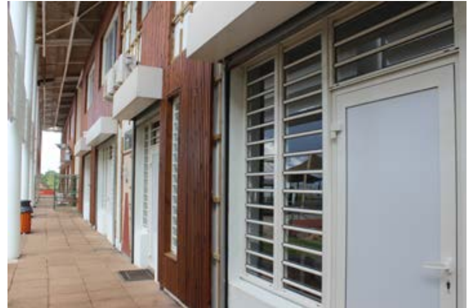
Les menuiseries sont intégralement changées.
